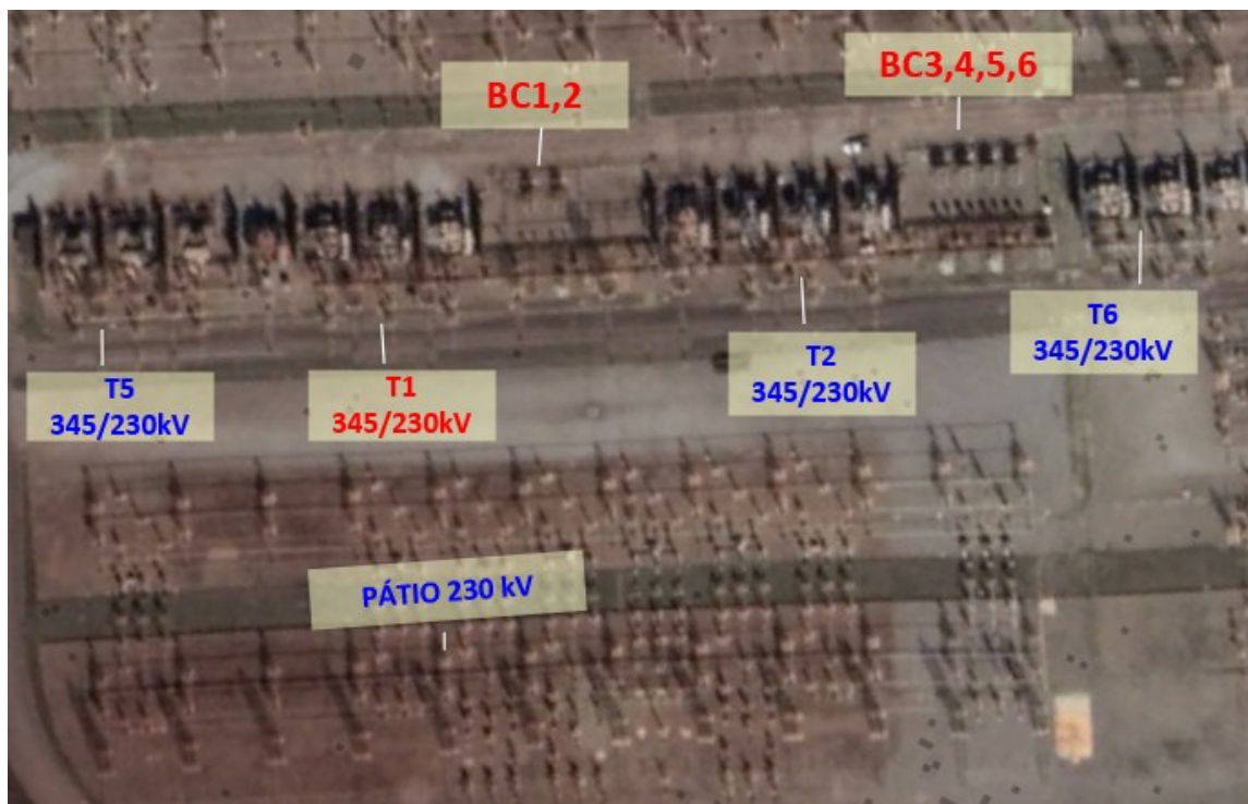
Figura 5-5 – Localização bancos transformadores 345/230 kV e dos bancos capacitores na SE Taquaril
